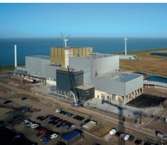
Dicht am Wattenmeer und an der Frisia Zout gelegen: das neue Reststoffkraftwerk in Harlingen (Foto: Joachim de Ruijter)
