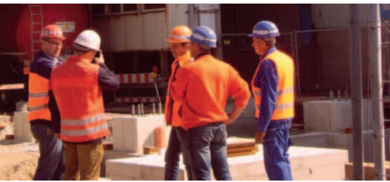
Visite de chantier par l'équipe de sécurité – les fondations pour le nouveau silo sont déjà visibles
